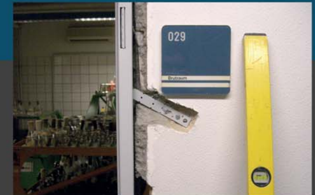
Einfacher Einbau neuer Stahlzargen
